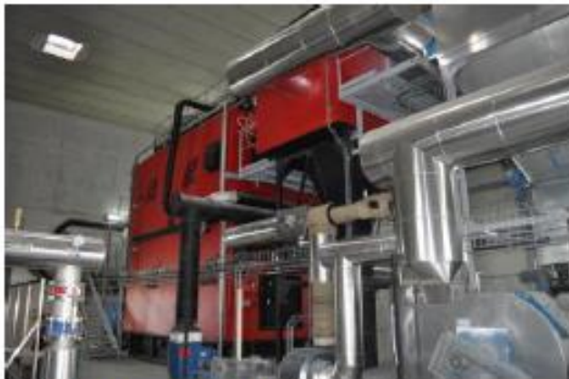
Chaudière de 6 MW
