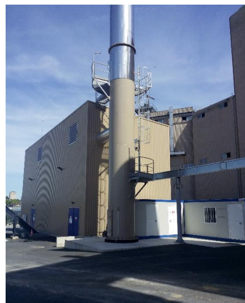
Abbildung 2 : Vyncke Heizkessel von Boortmalt (Issoudun, Frankreich)
