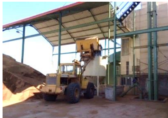
Figura 7: Strutture de El Cierzo per il centro logistico di biomasse
